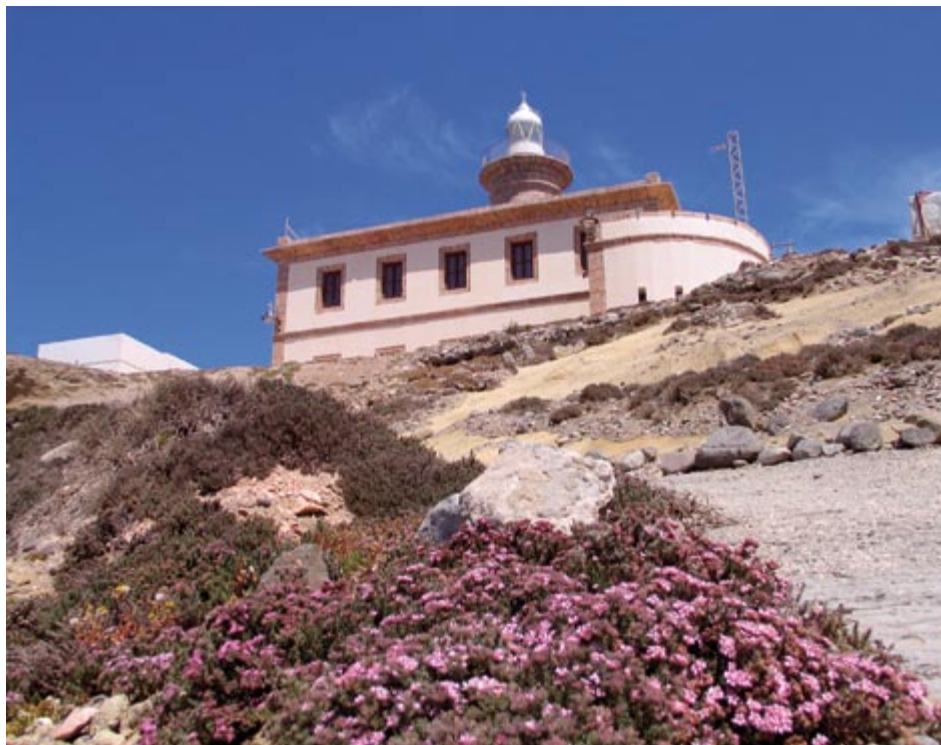
El edificio del faro (foto: J. C. Nevado).
