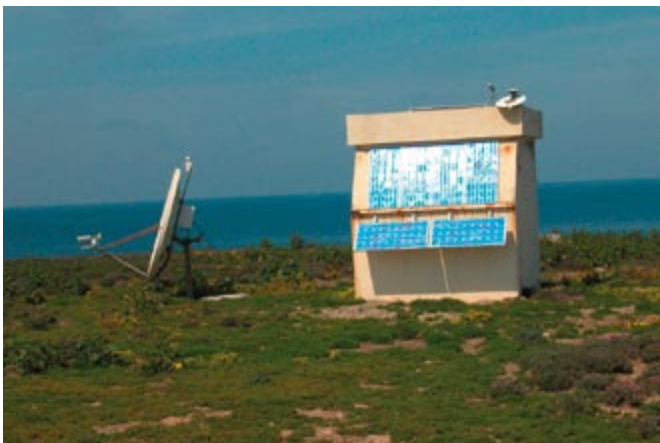
El barracón militar (dcha., foto: J. C. Nevado) y la estación sismográfica (izqda., foto: J. F. Mota) son dos de las construcciones de nueva planta en la isla.
