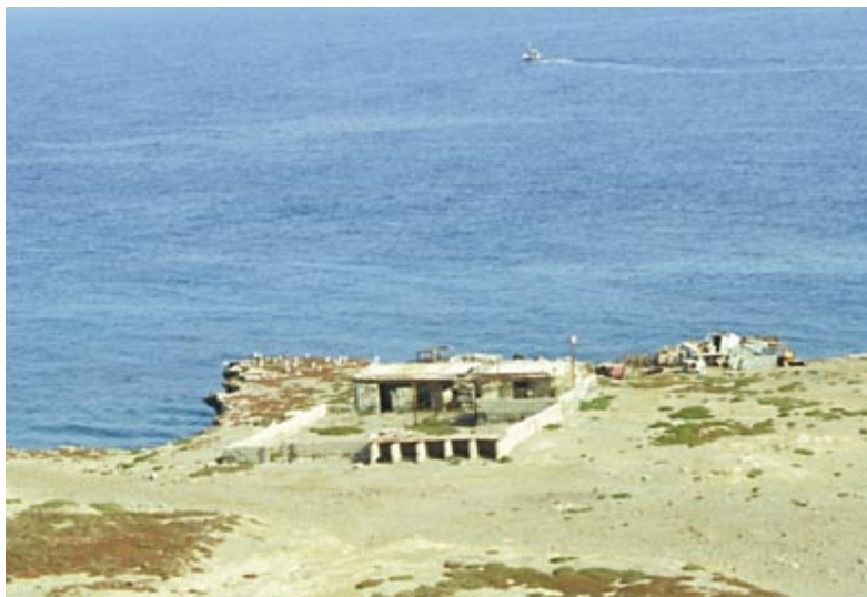
Las edificaciones e infraestructuras humanas restan un espacio vital a la biodiversidad de la isla, más aún teniendo en cuenta el reducido tamaño de Alborán. En la imagen (tomada en 1994), antiguas edificaciones aledañas abandonadas junto a uno de los núcleos de cría de la Gaviota de Audouin ( Larus audouinii ) en el extremo Oeste, las cuales actualmente se encuentran derribadas y suprimidas (foto: J. C. Nevado).
