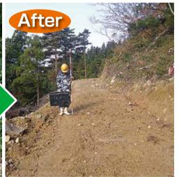
工期:平成30年6月20日~平成31年1月11日 施工場所:佐渡市 後尾 地内 発注者:新潟県 工事概要:森林基幹道開設工(延長301m、道路幅員4.0m) 担当者:下辺 義郎
