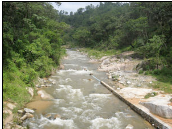
Tubería para recoger y llevar agua al poblado de Nuevo Paraíso
