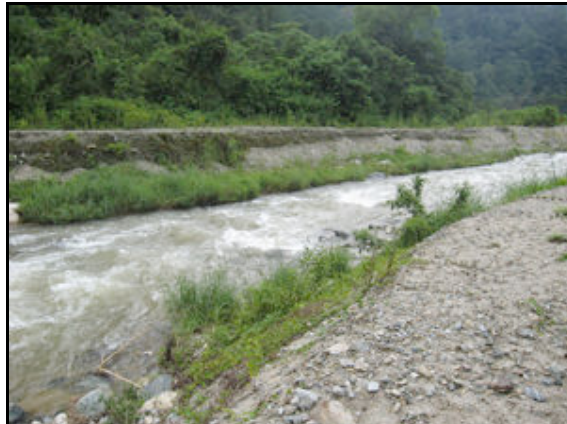
Erosión lateral del cauce a la altura del Ejido Siete de Octubre
