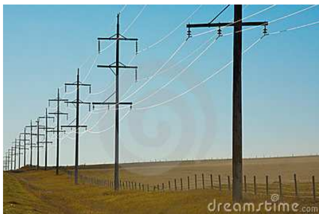
368. att. Dažāda sprieguma elektrolīnijas: 20 kV, 110 kV un 400 kV. (Latvijā attiecīgi 330 kV) 273
