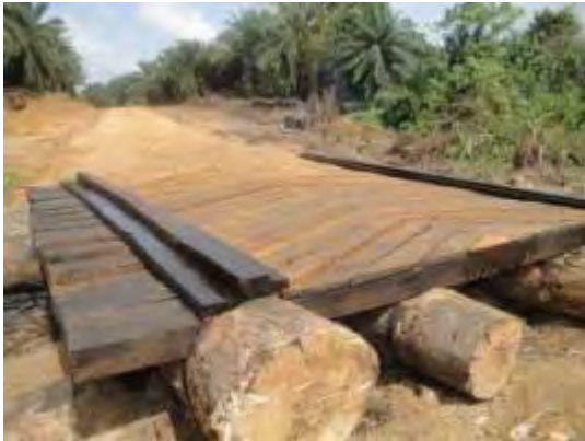
Pont de platelages en construction sur une route permanente
