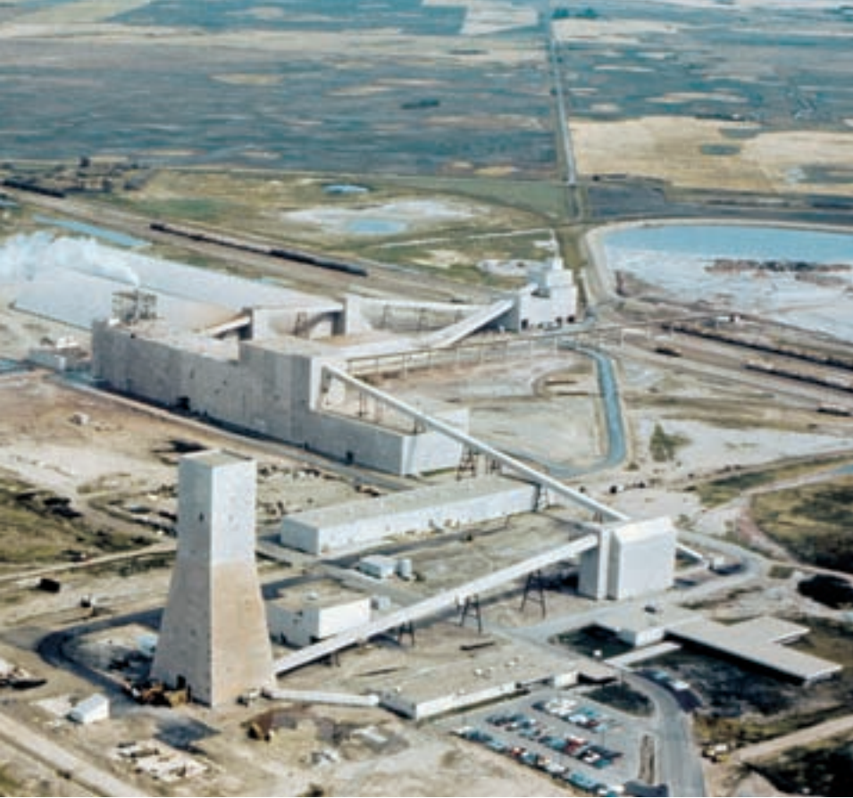
Die Übertageanlagen des Kaliwerkes der Alwingsal in Saskatchewan Anfang der 1970er Jahre
