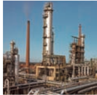
Die Wintershall-Raffinerie Salzburg im Jahr 1969
