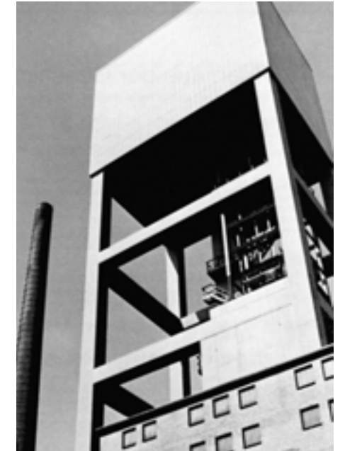
oben 1970/71 wurde der Schacht Grimberg des Kaliwerkes Wintershall zu einer Zentralschachtanlage umgebaut. Der markante neue Föhrturm wurde mit einer Achtföhrtförderung ausgeröhrt.
