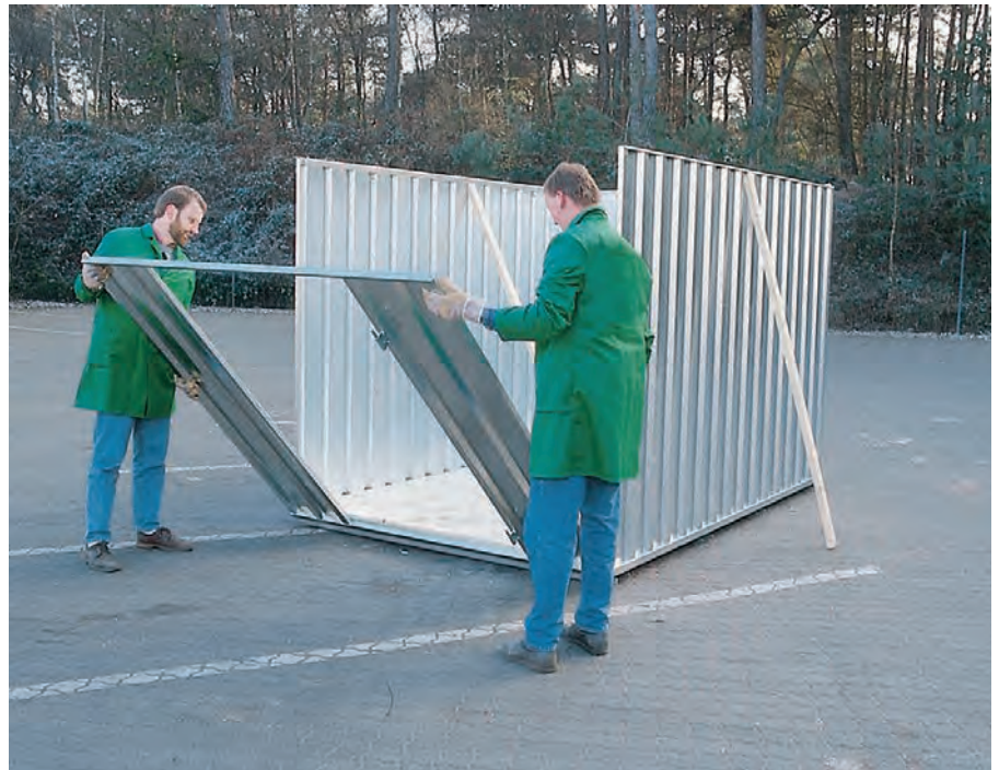
Aufstellen der Seiten- und Stirnwände.
