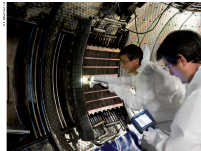
Maintenance sur l'installation Tore Supra.
