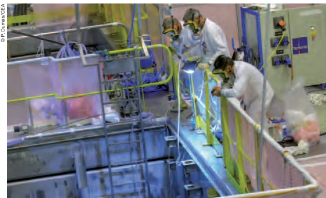
Techniciens immergeant un robot dans une piscine de l'installation MAR 400, en cours de démantèlement.
