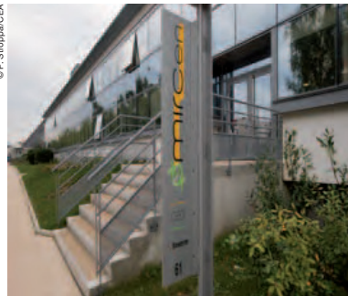
Vue du bâtiment MIRCen.
