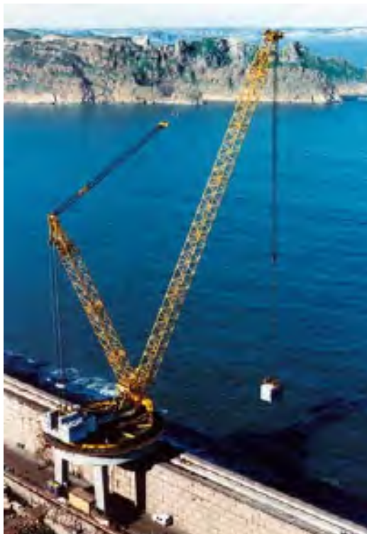
Work on the Príncipe de Asturias sea wall, El Musel harbor, Gijón.
