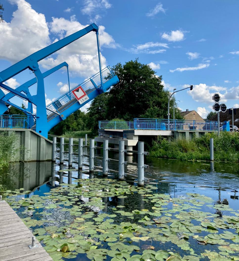
Klappbrücke in Liebenwalde
