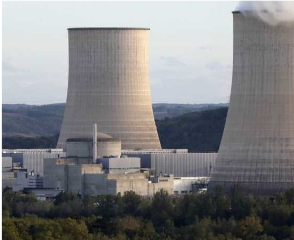
La centrale nucléaire de Golfech au mois d'octobre dernier. L'un des deux réacteurs est encore à l'arrêt. THIERRY DANIEL VIDAL / « SUD OUEST »
