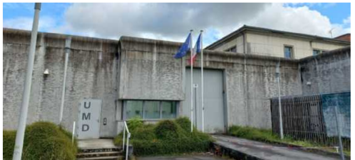
Les unités Claude et Moreau seront démolies puis reconstruites d'ici 2027. J.J.
