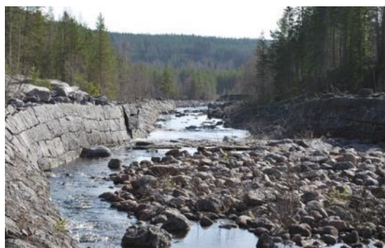
Räbbstuguforsen är kanaliserad.
