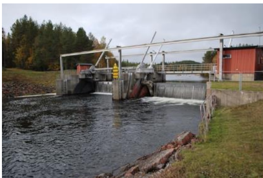
Regleringsdammen vid Faxälvsgrönen.
