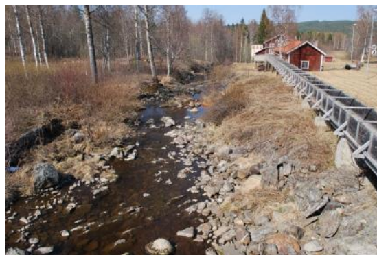
Bruksån och vattenrännan som leder till bruket.
