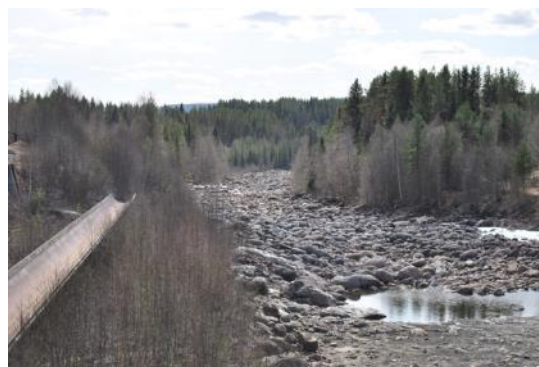
Timmerrännan och torrlagda älvfåran strax nedanför regleringsdammen.
