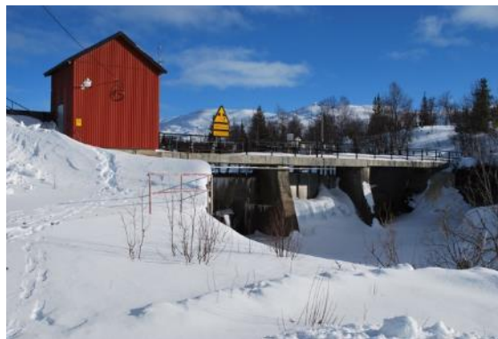
Regleringsdammen som ligger strax bredvid Kraftverket.
