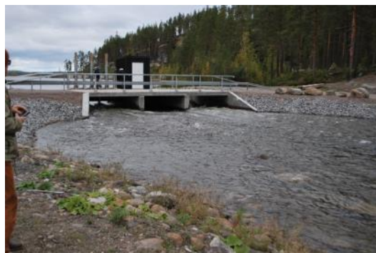
Betongkonstruktionen vid utloppet från Sporsrsjön.
