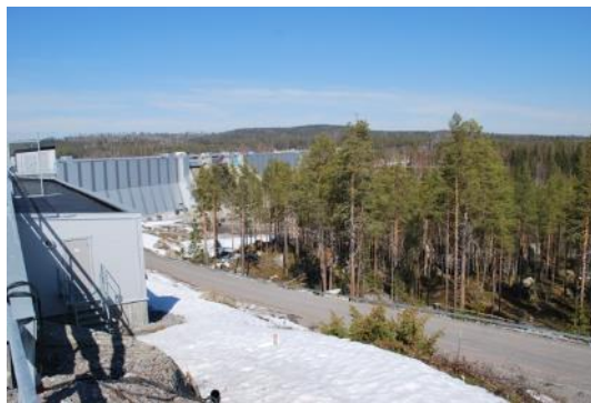
Till höger om vägen i bilden, skulle fiskvägen ha sin sträckning.
