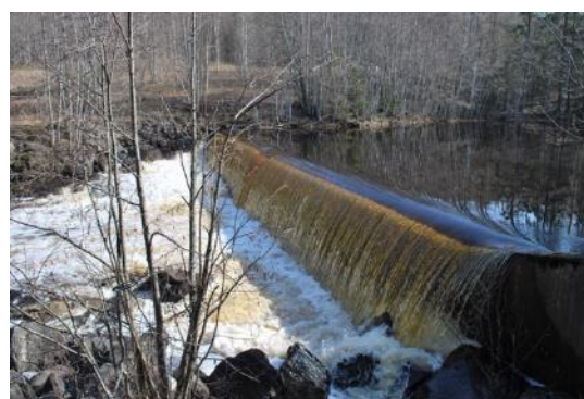
Tröskel i betong strax ovanför (ca 120 m) utloppet från tunneln.
