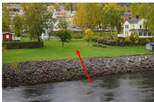
Dammvallen som hindrar kanalens vatten att strömma ned till Ångermanälven, innan regleringen strömmade vattnet genom kanalen.
