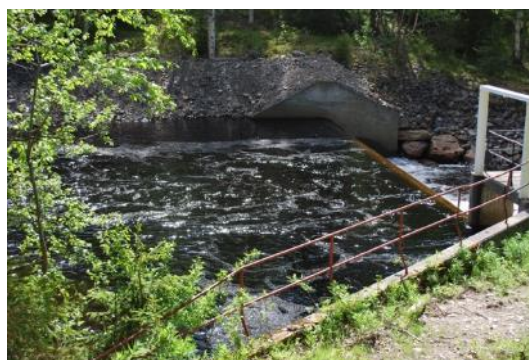
Dammen/tröskeln och intaget till tunnel.
