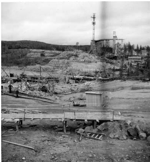
Byggnationen av Storfinnforsens kraftverk. Bild: Murberget.
