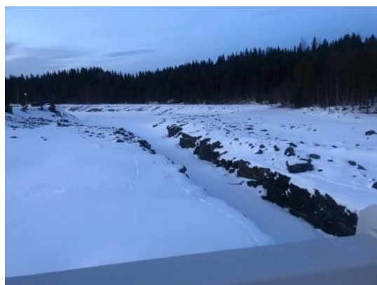
Kanalen som leder in till dammen.
