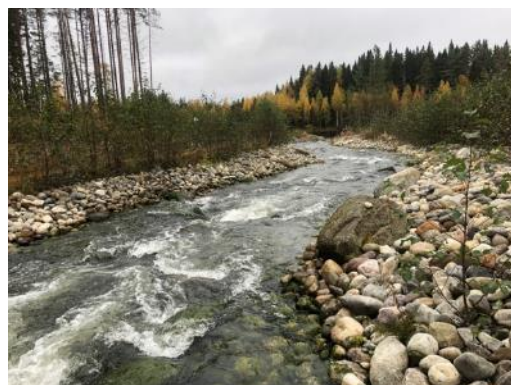
Omlöpet som ligger vid Norrströmmen.
