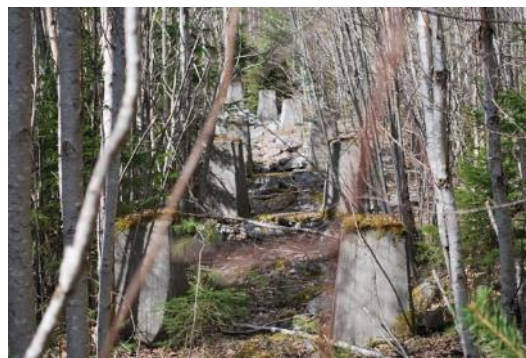
Betongfundamenten till timmerrännan.
