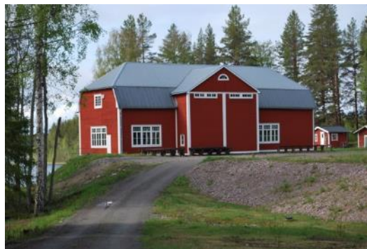
Gamla Lövön kraftstation.
