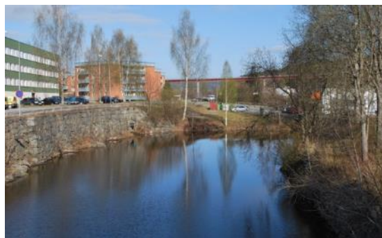
Den övre delen av den gamla kanalen, vattnet strömmade fritt igenom kanalen innan kraftverket byggdes.
