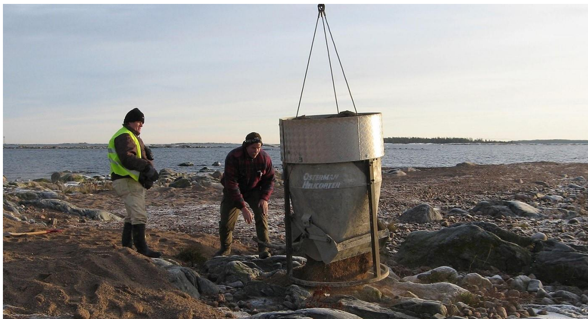
Figur 15. Stenarna 19/12 2007. Ulrik Lötberg och Per Nordkvist styr och tömmer tunnan med grus. Helikoptern siktade mot den med gula västen. Bråttom att sprida ut gruset med spadar och krattor innan nästa tunna anländer. Foto Länsstyrelsen Uppsala, Niina Salmén.
