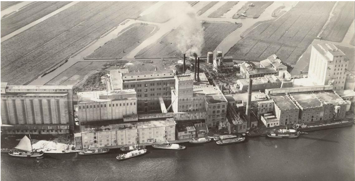
Van oorsprong afwisseling in schaal en hoogte van bouwvolumes en in plaatsing en verscheidenheid van de bouwvolumes en voornamelijk platte daken met her en der een zadeldak, foto 1931 21.04972
