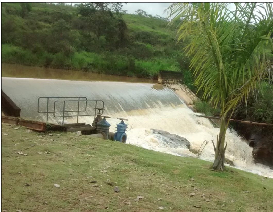
Figura 130 - Vertedouro de captação de água do córrego Candidópolis
