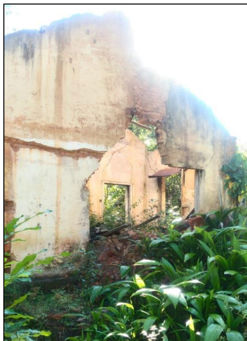
Figura 227 - Casa de apoio da Usina Hidrelétrica Ribeirão São José
