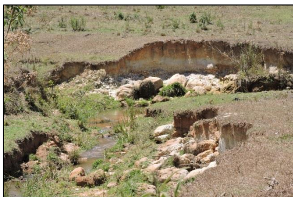
Figura 107 - Erosão próxima a ETA Chapada
