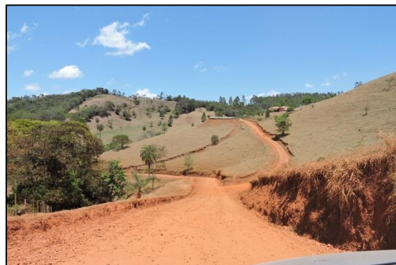
Figura 105 - Taludes de estradas e solo sem proteção vegetal
