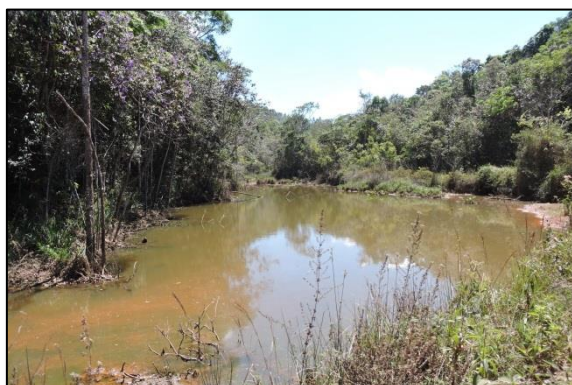
Figura 95 - Barramento assoreado com captação a jusante
