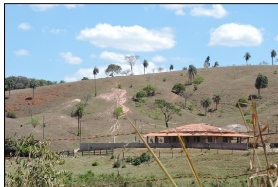
Figura 115 - Erosão em propriedade particular
