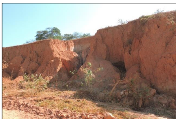
Figura 77 - Movimentação de massa em talude para corte de estrada
