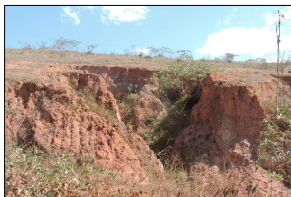
Figura 70 - Erosão em beira de estrada Bacia do Córrego Candidópolis 02
