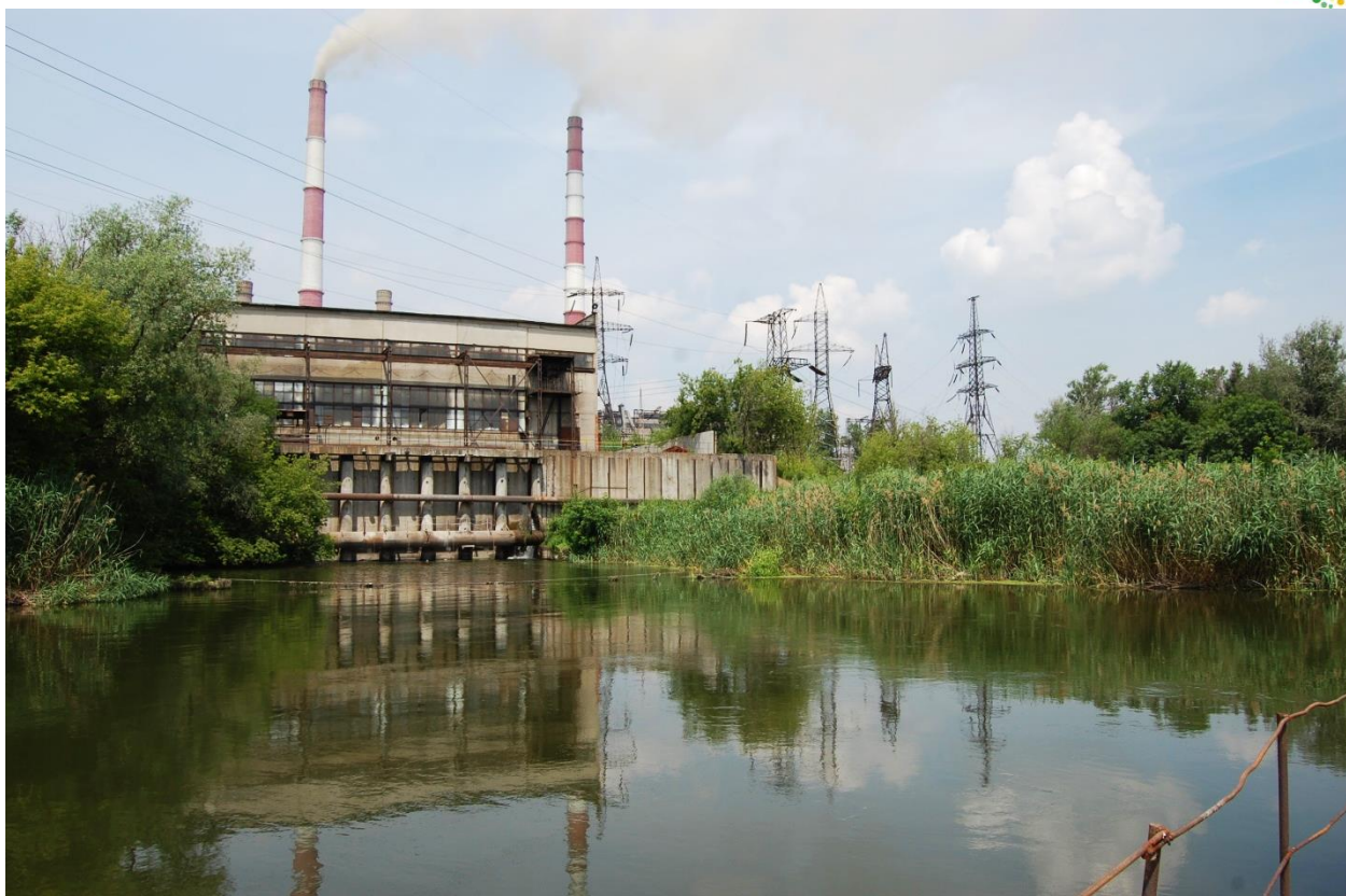
Мал.12.2. Берегова насосна станція №3 с водопідвідним каналом від р.Сіверський Донець
