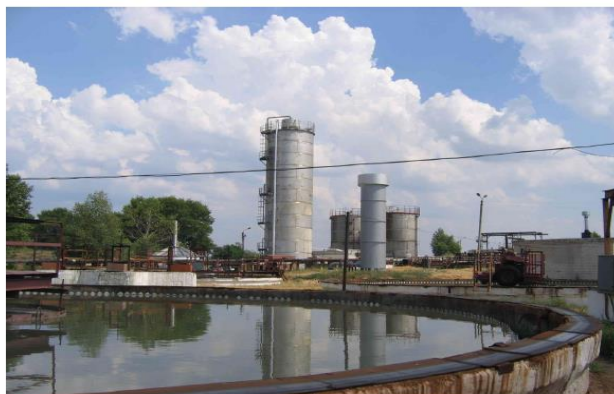
Анаеробний ІС-реактор
