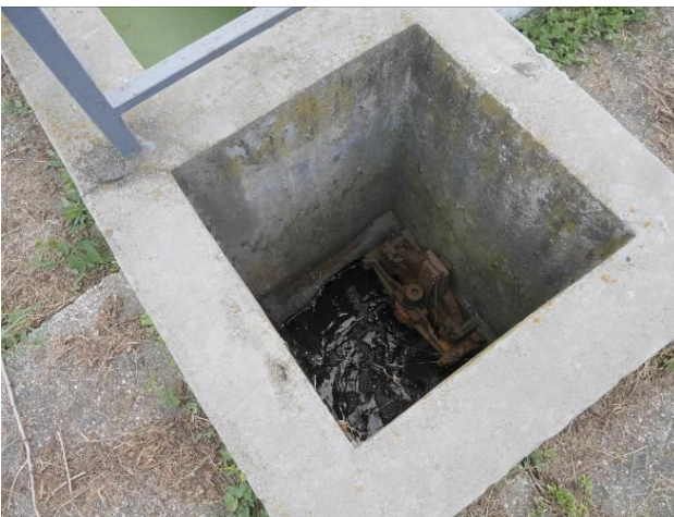
Fertőtlenítő medence tisztított szennyvíz elvezető aknája
