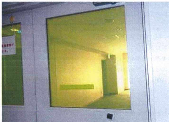
防虫フィルム施工例
