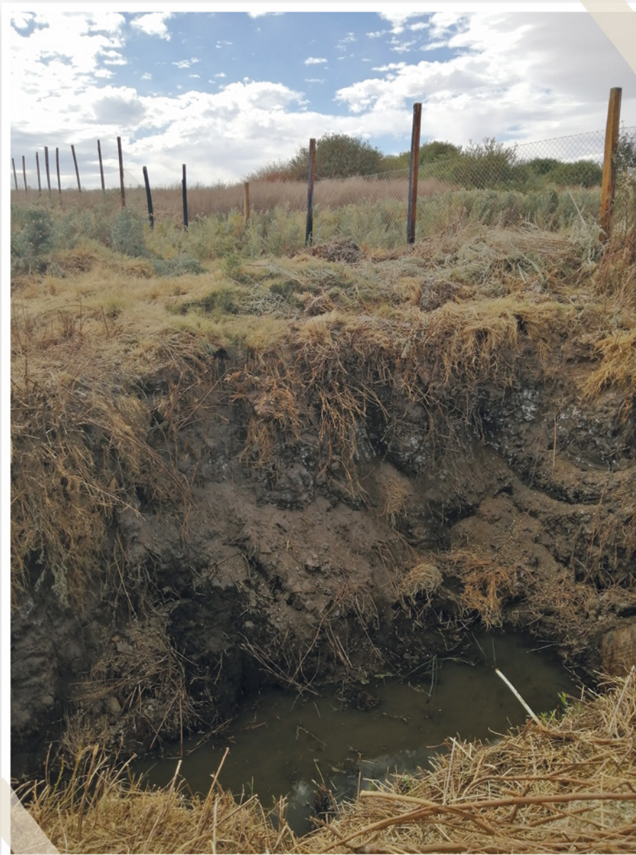
Fotografía 4. Excavación y poza en desecación con presencia de animales.
