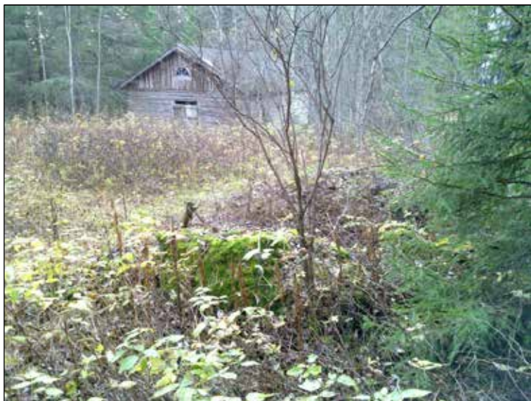
Kivetty rakennuksen perusta heinikon peittämänä myllyn koillispuolella.
