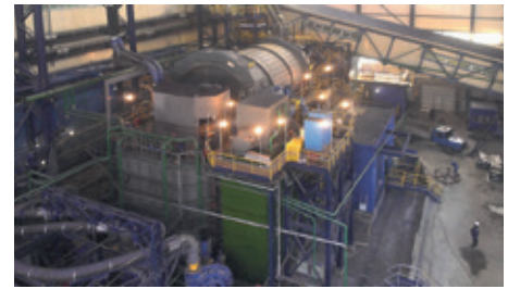
Golderz-Aufbereitungsanlage mit ContiClass®System
