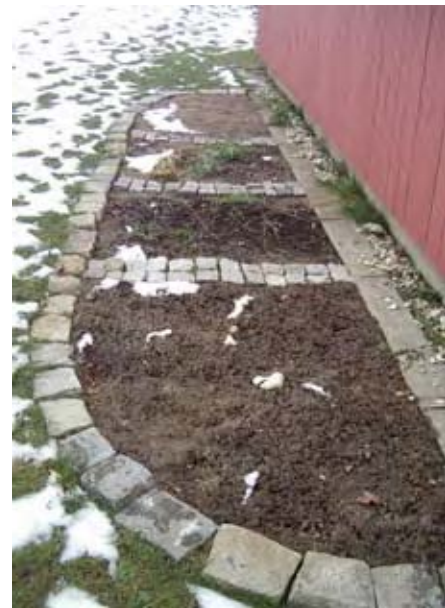
Abbildung 2: Offener Boden am Schulgebäude
