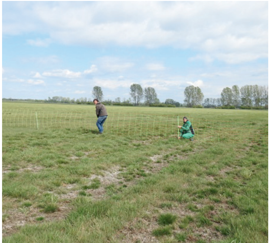
Abb. 68 Errichtung eines Schutzzaunes für einen Brutplatz des Brachvogels in den Belziger Landschaftswiesen. Foto: N. Eschholz
