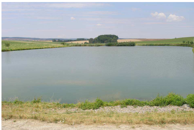
Obr.č.6 Akumulační nádrž
