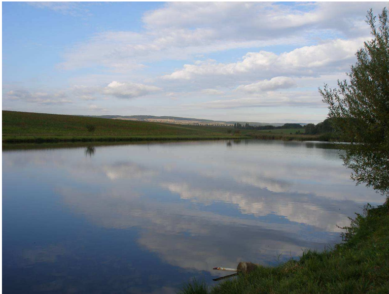
Obr.č.2 Akumulační nádrž
