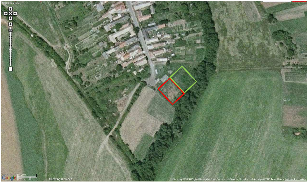
Obr. 1: Poškodené pole „A“ čistiarne Hontianske Moravce – satelitná snímka
