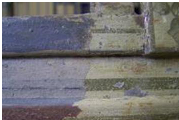
20. kép. A kalitka felső festékrétegének eltávolítása
