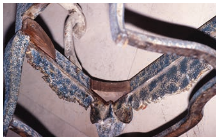
12. kép. A káva és az alatta lévő eredeti bal, valamint az eltérő mintázatú, pótolat előoldali faragvány hátoldala
