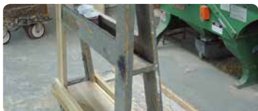
Holz – splittert und fault
