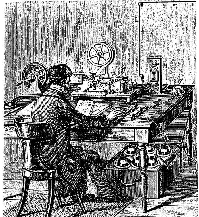
Morsetelegrafiestation: Man sieht den Morseschreiber (V), den Leitungsschutz in Form von Hochspannungssicherungen (M), den Linienstromanzeiger (g), ausgeführt als Tangentenbussole, die Morsetaste und die galvanische Batterie mit sechs Einheiten
