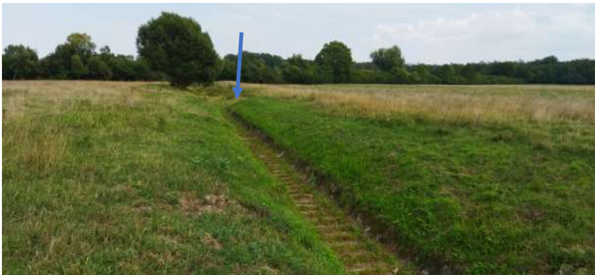
A tervezett visszavezetés helye, a gát alatt, a burkolt szakasz végénél
