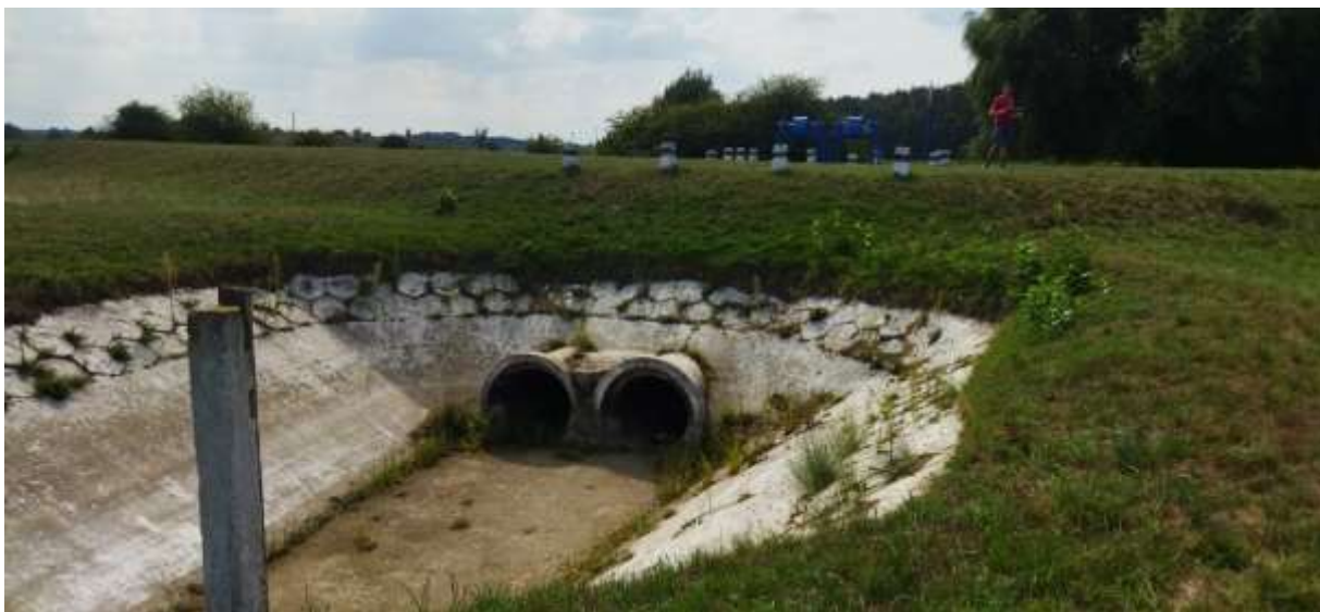
Kéttáblás zsilip a Bagaméri-tározó völgyzáró gátján, a Nagy-éren
