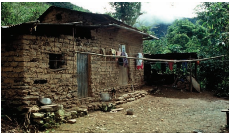
Foto 5.16 Casa familiar de paredes de adobe, techo de calamina y suelo de tierra en la comunidad de Yucupi
