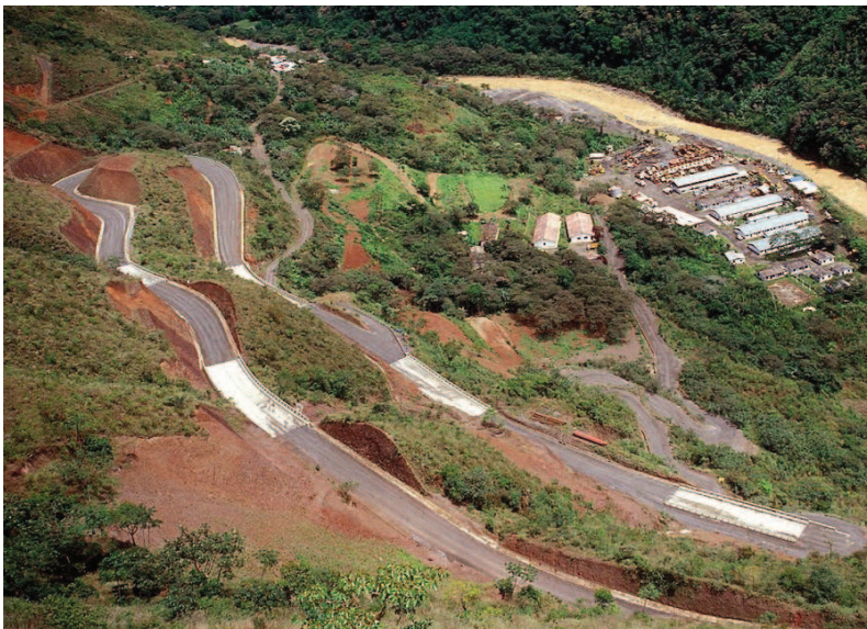
Foto 4.12 Parte del trazado de la carretera Cotapata-Santa Bárbara (PK. 40-43)
