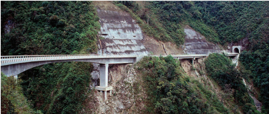
Foto 4.9 Viaducto y túnel de la nueva carretera en el área de Socosani
