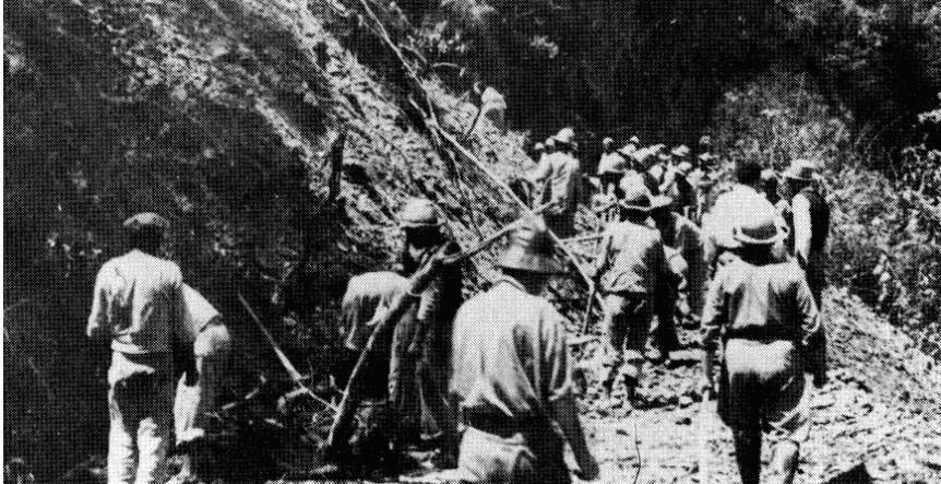
Foto 4.6 Trabajos de construcción de la carretera a Buena Tierra (1941)
