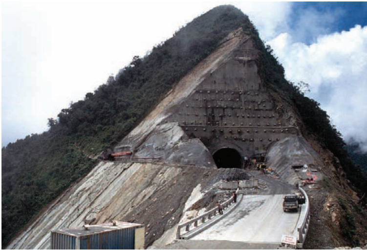
Foto 4.10 Entrada norte del túnel de San Rafael
