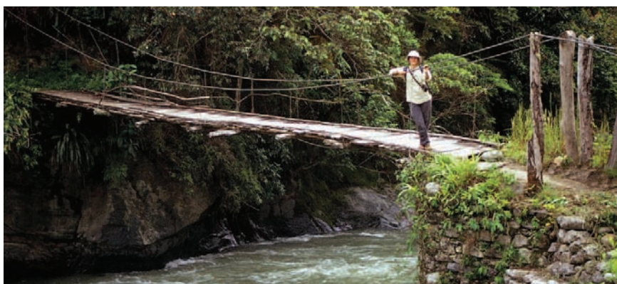
Foto 4.15 Puente sobre el río Huarinilla en la comunidad de Yucupi-Chimani
