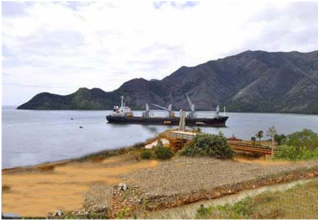
Baie de Kouaoua Loading Berth
