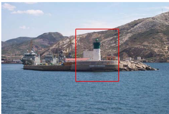
Dique de Curra Light
