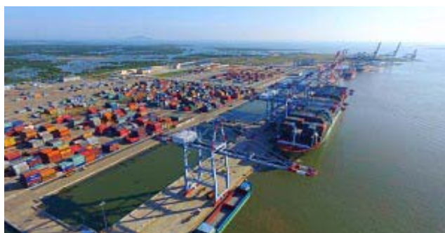
Vung Tau Container Port
