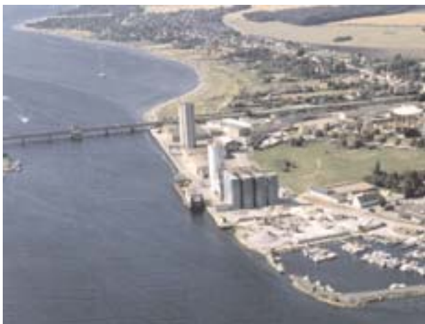
Vordingborg Sydhavn—The Masnedesund Bridge
