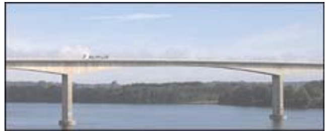
The Als Sund Bridge
