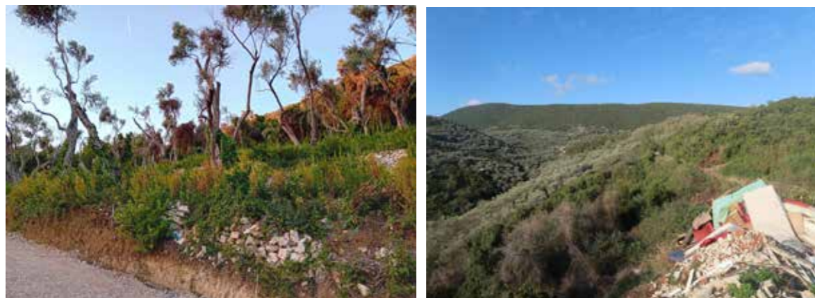
Rrugë të zgjeruara në mënyrë joadekuate; Deponi ilegale
