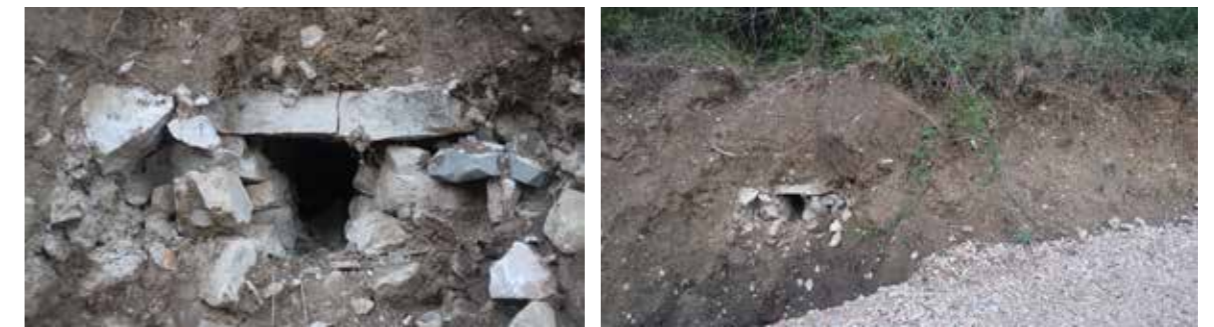
Zbulohet kanali i vjetër që shkon nën nivelin e tokës
