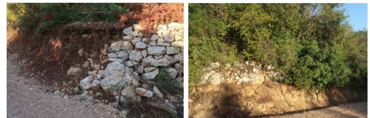
Pjesa e shembur e nënmurit dhe nënmuri që ka mbetur mbi segmentin e gërmuar të rrugës, rruga e zgjeruar drejt Kronit të Vakfit, 2023.
