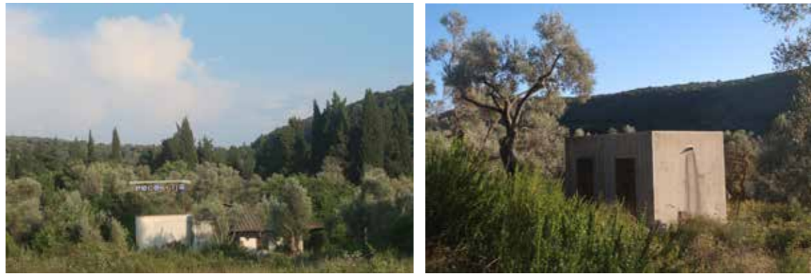
Recepioni i kompleksit; Kuzhina e përbashkët në kuadër të auto kampit
