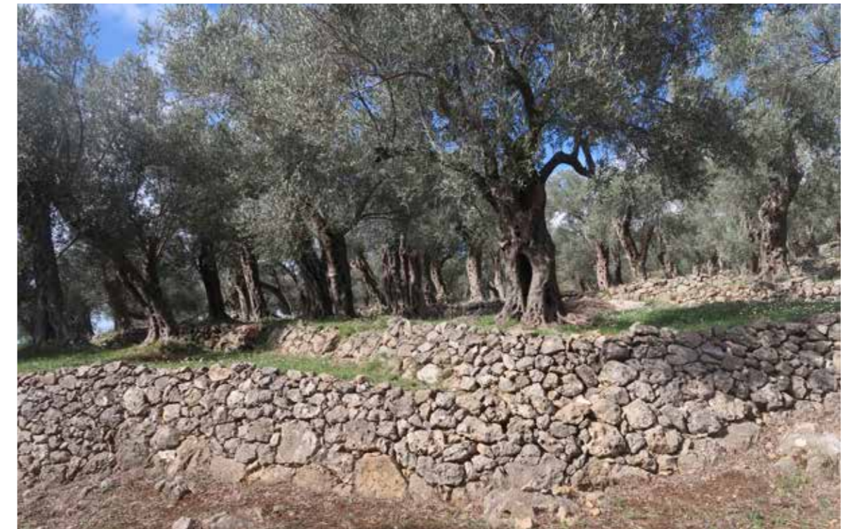
Nënmuret nga muri i thatë
