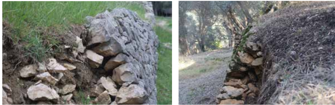
Nënmuret e tarracave me fytyrë dhe mbushje të dushme të murit të thatë
