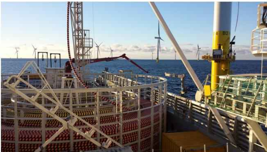
Figur 4-19. Ett kabellägningsfartyg installerar kablar på havsbotten i en vindkraftpark.
