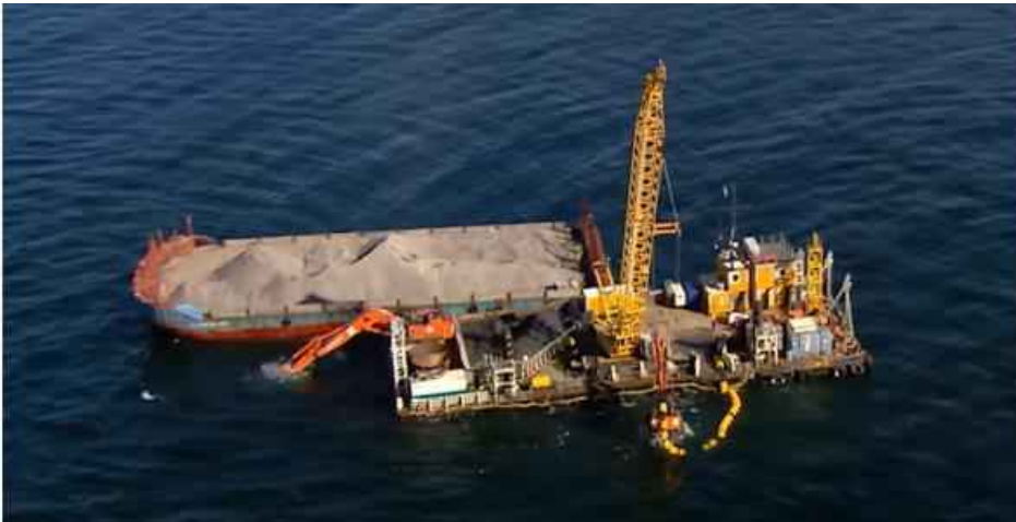
Figur 4-14. Förberedande arbeten i form av muddring med mudderverk (Källa: Jan De Nul).
