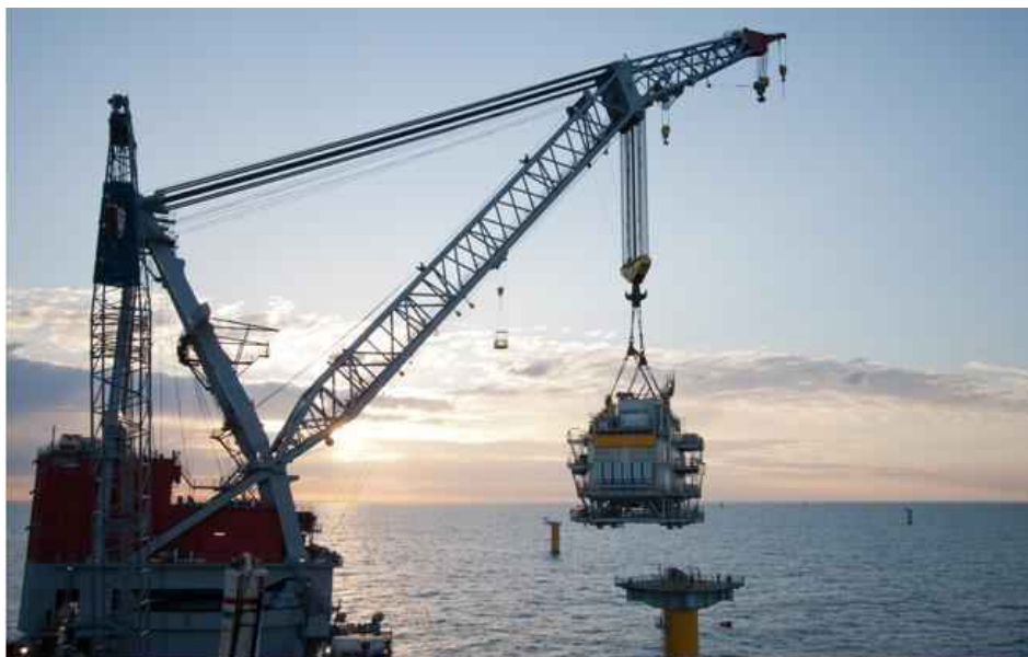
Figur 4-20. Installation av transformatorstation genom lyft.
