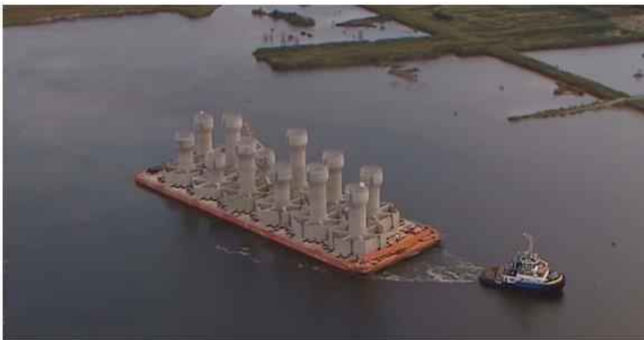
Figur 4-15. Bogsering av fundament på pråm (Källa: Jan De Nul).
