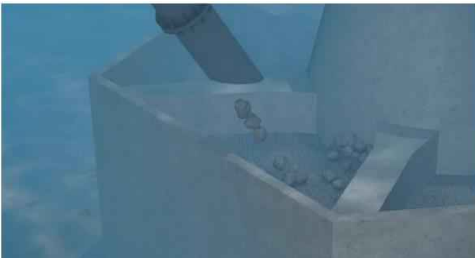
Figur 4-17. Fundamentets celler fylls med ballast (Källa: Jan De Nul).
