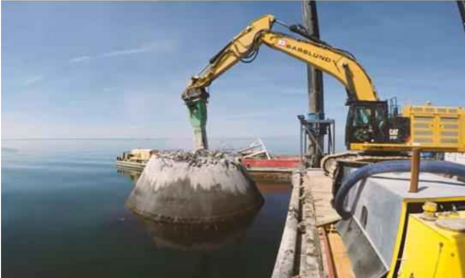
Figur 4-23. Demontering av fundament. Källa: Dong Energy.
