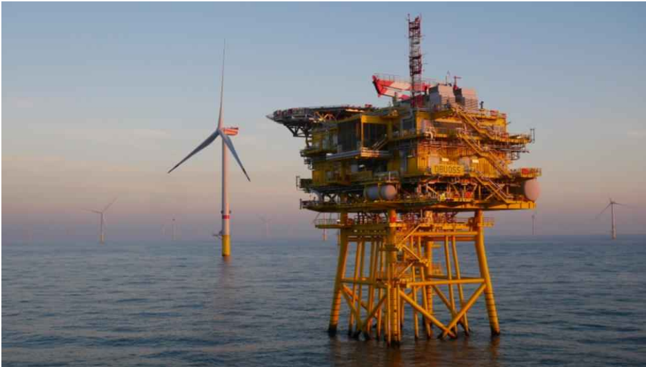
Figur 4-13. Exempel på transformatorstation på fackverksfundament.
