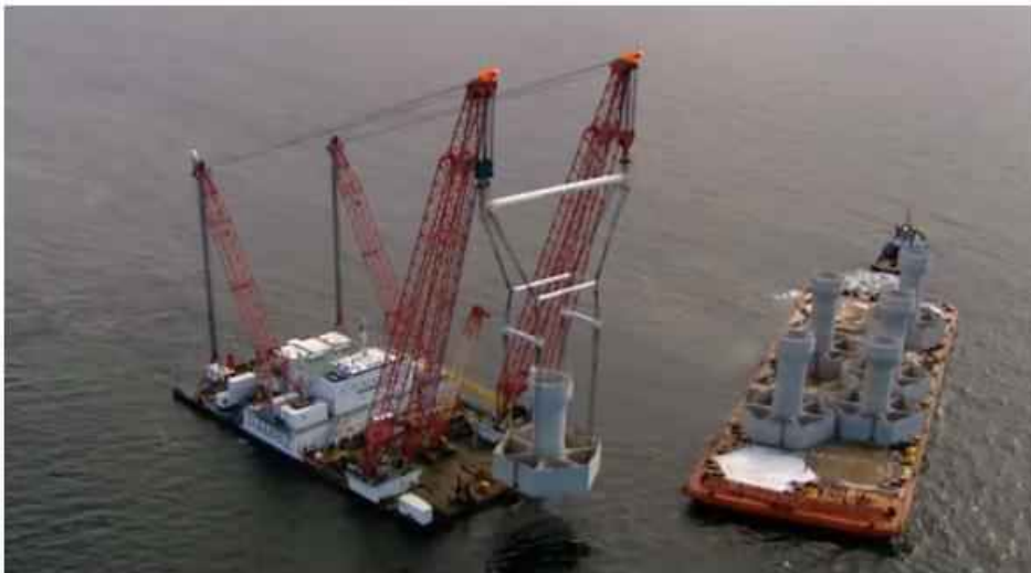
Figur 4-16. Installation av gravitationsfundament (Källa: Jan De Nul).
