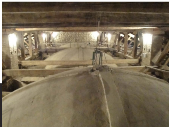
VISTAS DEL ENTRAMADO DE LAS BÓVEDAS Y ENTRAMADO DE LA CUBIERTA DEL ÁBSIDE
