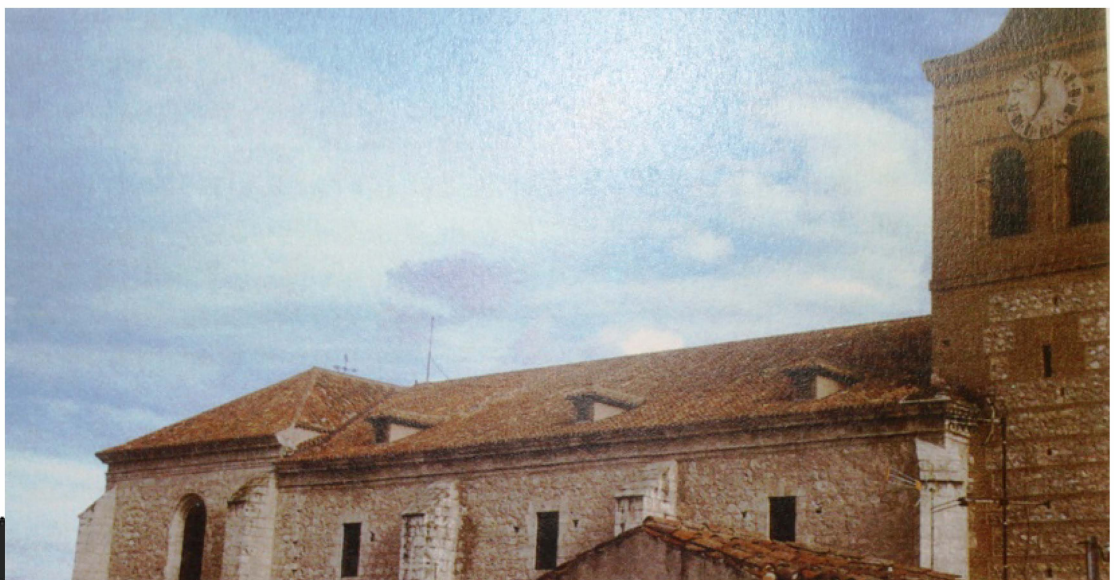
VISTA EXTERIOR DE LA CUBIERTA
