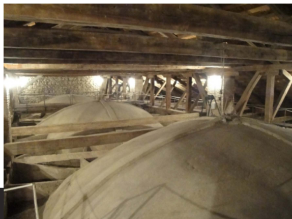
ENTRAMADO DE CUBIERTA Y CÚPULAS
