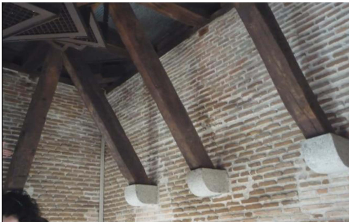
MÉNSULAS DE APOYO Y UNA DE LAS BUHARDAS
