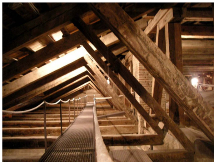
HAY MADERA ATACADA DE XILÓFAGOS QUE HA SIDO TRATADA QUÍMICAMENTE. LA MADERA VIEJA ESTÁ TRABAJADA CON AZUELAS. EN LA NUEVA SE VEN LOS CORTES LIMPIOS DE LA SIERRA MECÁNICA
