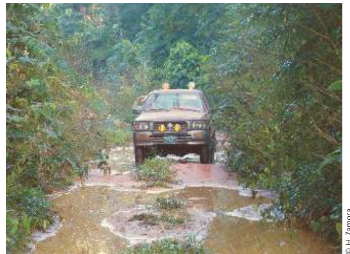
Figura 7. Erosión del suelo debido a la lluvia y al paso de vehículos, sector Palma.
