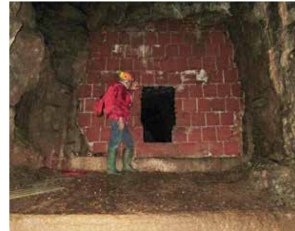
Fig. 6: Uno dei muri (punto 4) che restringono la sezione della galleria, influenzando sulla circolazione dell'aria. Fig. 6: One of the walls (point 4) that narrow the section of the gallery, affecting air circulation.
