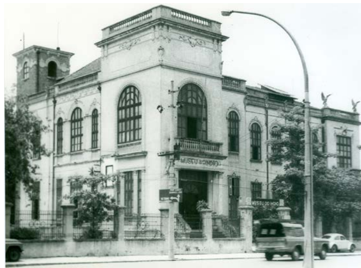
Foto 1 - Fachada do Museu do Índio na rua Mata Machado, 1953. Foto: Acervo Museu do Índio.
