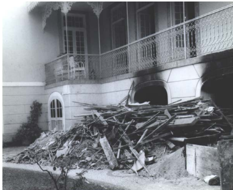
Foto 4 - Imagem da fachada lateral do prédio central do Museu do Índio, 1998. Foto: Acervo Museu do Índio.
