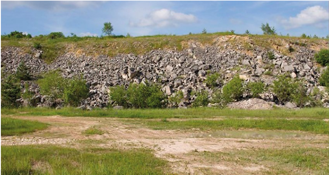
Fig. 2. Wiek Quarry in Ogrodzieniec (photo by Nikodem Mazur). Рис. 2. Кар'єр «Век» в Огородзінцю (фото Нікодема Мазура).
