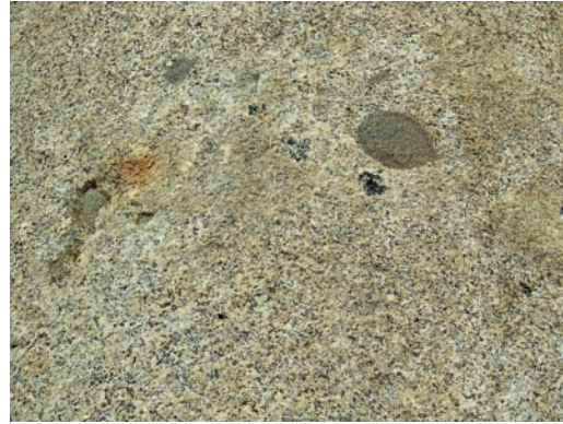
Figura 7: inclusi di pinite (grigio) e di schörlite (nero) presenti in una colonna nella porta di accesso della Torre di Pisa. Tale tessitura è molto comune nel granito gigliese della costa est.
