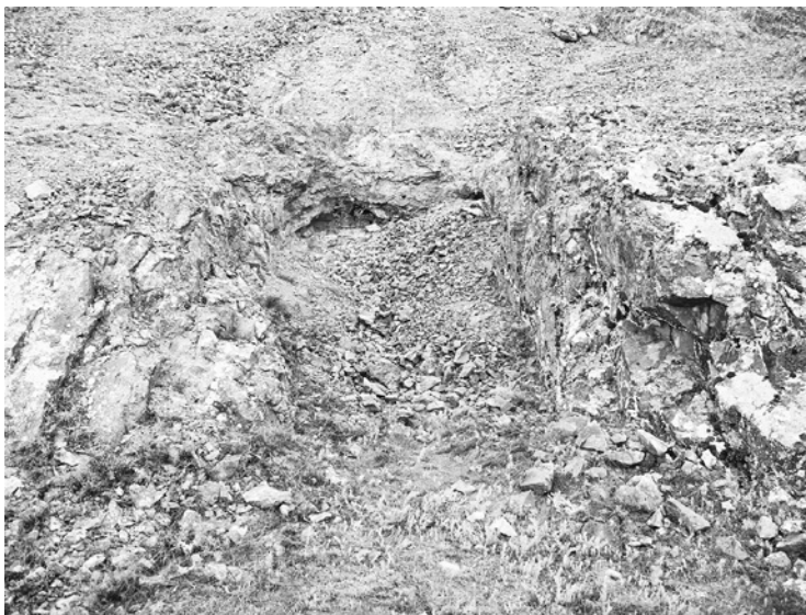
Слика 5: Леце - Урушена галерија
