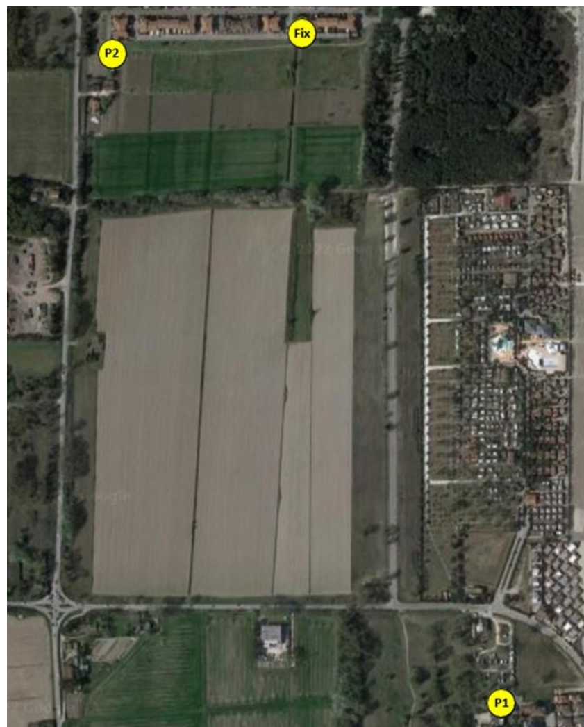
Figura 47 - Vista aerea (rilievi fonometrici ante operam ).
