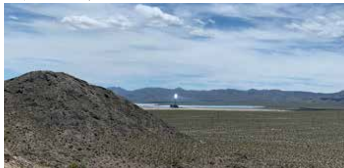
Ivanpah Solar Array
