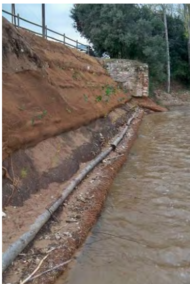
Detalle del talud finalizado
