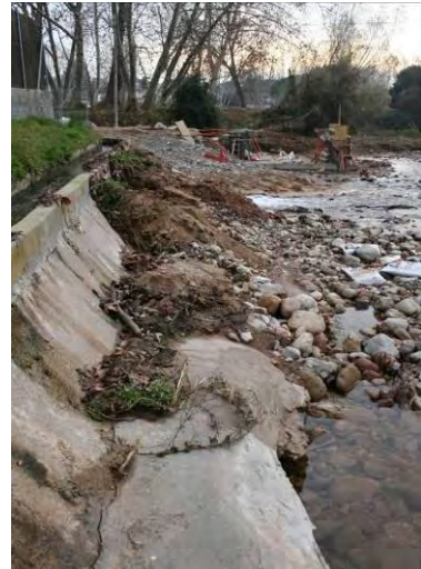
Imagen de la acequia de hormigón dentro el cauce, antes de la intervención.
