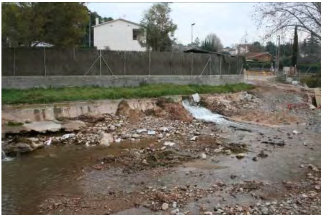
Imagen de la zona antes de la intervención
