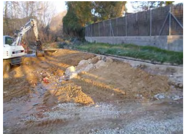
Proceso de reperfilado de los márgenes
