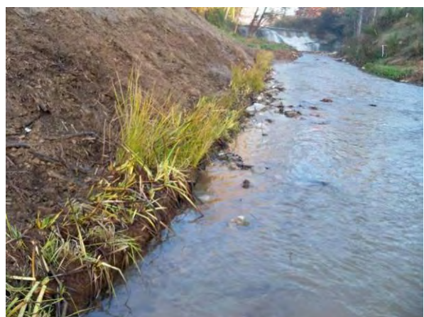
El tramo del río con los rollos vegetalizados una vez instalados.
