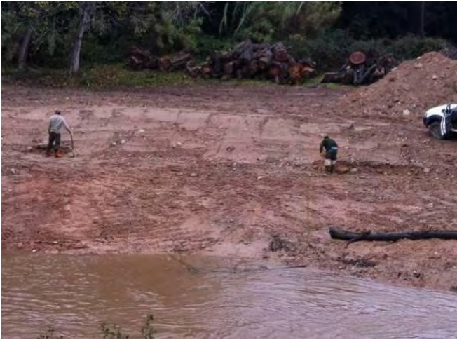
Imagen de la zona antes de la realización de la ribalta
