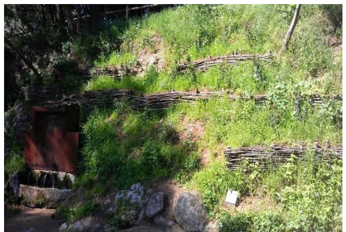
Imagen del talud ya vegetado después de tres meses.
