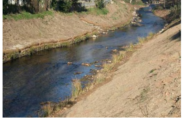
Imágenes generales de la Rollada viva riparial una vez instalada.
