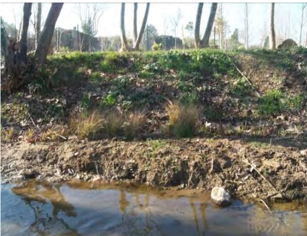
En la imagen los herbazales tipo Plant Carpet instalados.
