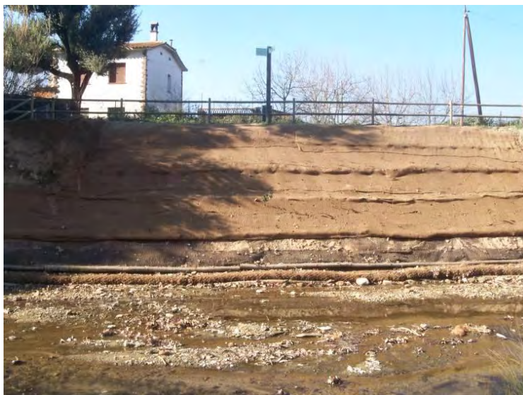
Vista del entramado finalizado
