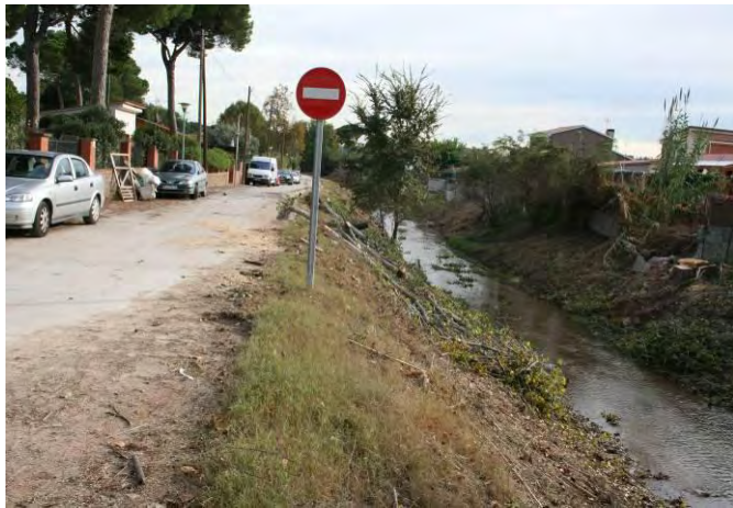
Tramo con la caña retirada
