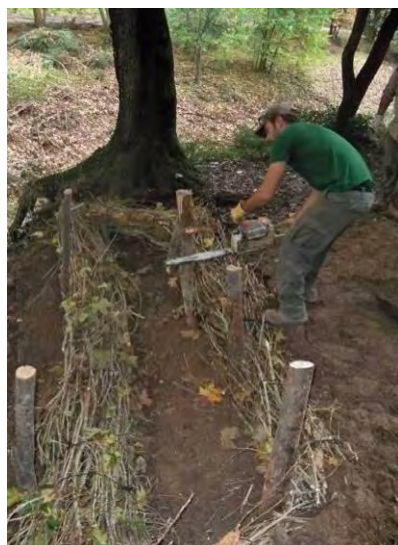
Instalación de fajinas
