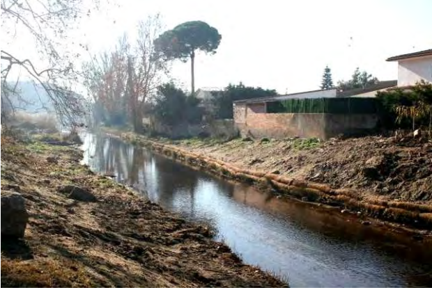
Imágenes generales de la Rollada viva riparial una vez instalada.
