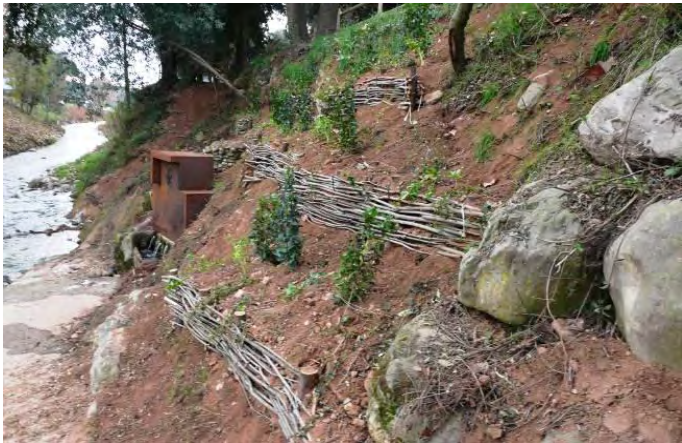
Diferentes imágenes de detalle de los trenzados
