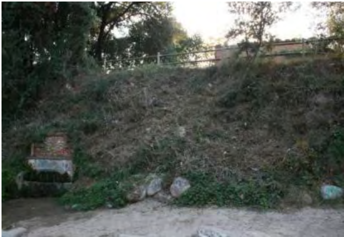
Imagen inicial del talud
