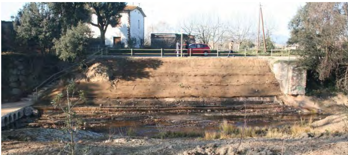
Imagen general del talud finalizado.
