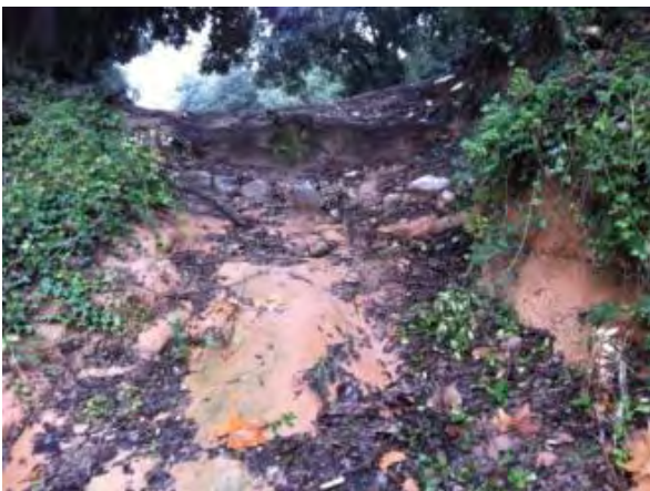
Estado inicial del talud
