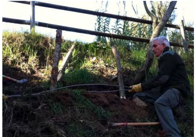
Proceso de construcción
