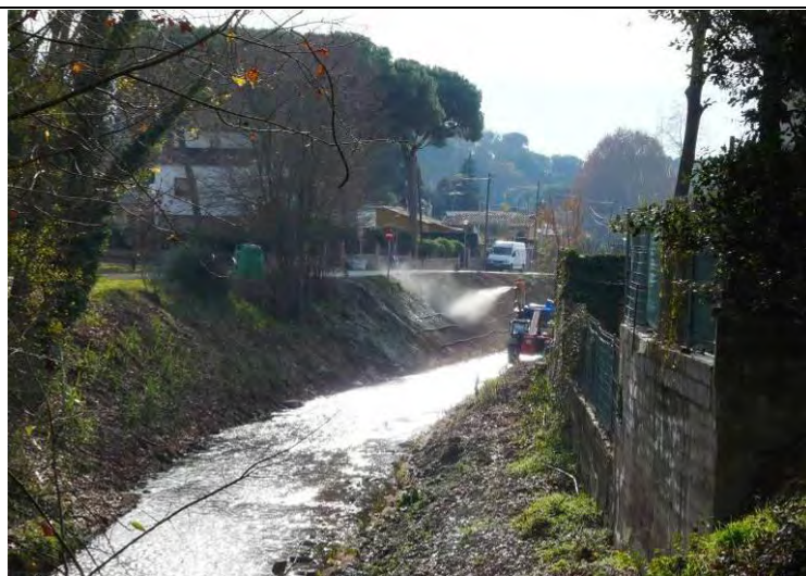
Proyección de la hidromanta tipo HydraCX 2 en el margen izquierdo del río Tenes aguas abajo de la fuente de Sant Cristòfol
