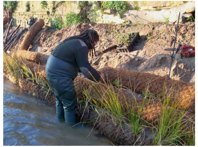
Proceso de atado de las diferentes líneas de rollos
