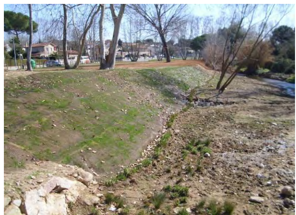
Proceso inicial de vegetación de la geomalla
