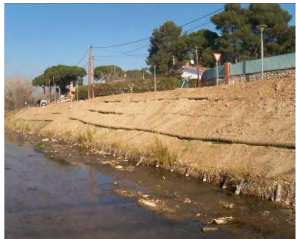
Talud con el enrejado hidromantado
