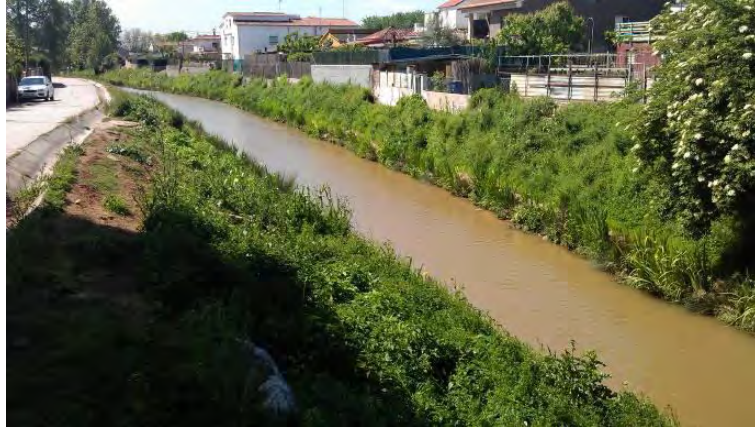
Imagen del talud con el enrejado en proceso avanzado de revegetación.
