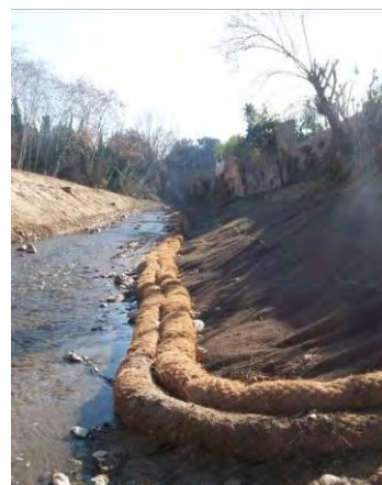
Imagen de la zona una vez realizadas las actuaciones.
