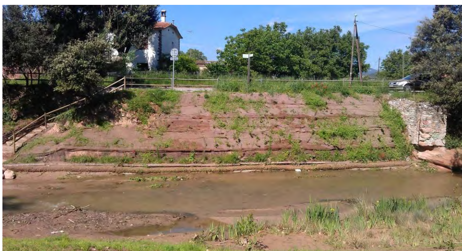
Imagen del entramado en proceso de revegetación.
