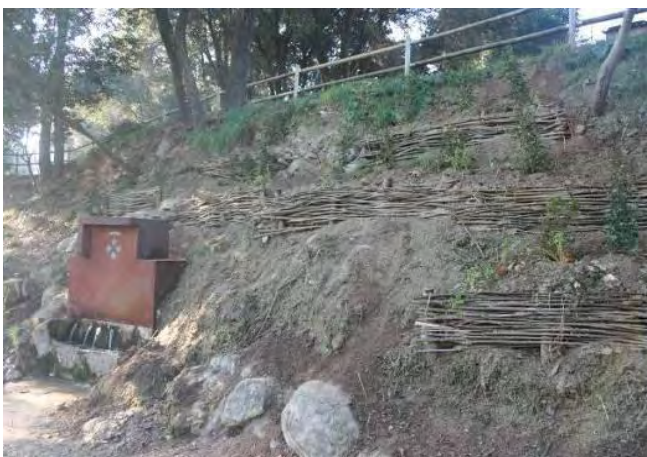
Imagen general del talud de la fuente de Sant Cristòfol una vez finalizada la actuació.
