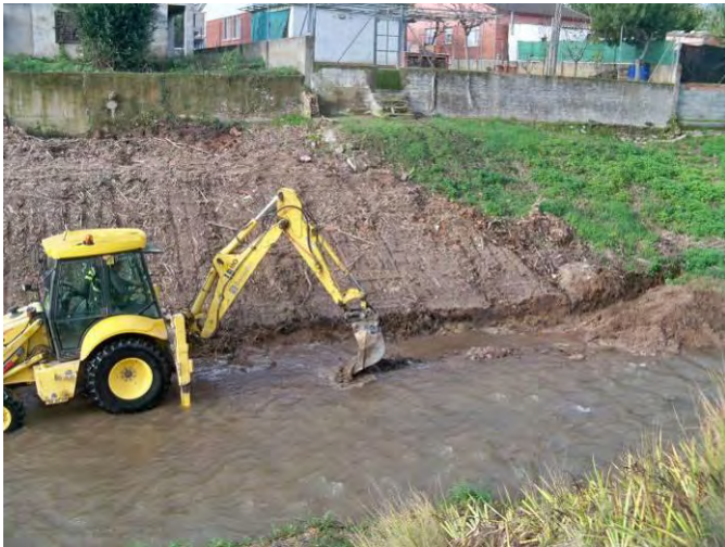
Realización de la zanja con medios mecánicos
