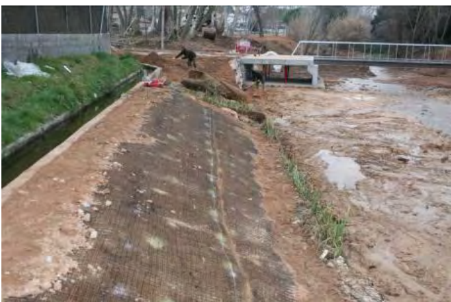
Geomalla permanente tipo C350-Vmax con rollo vegetalizado en la base
