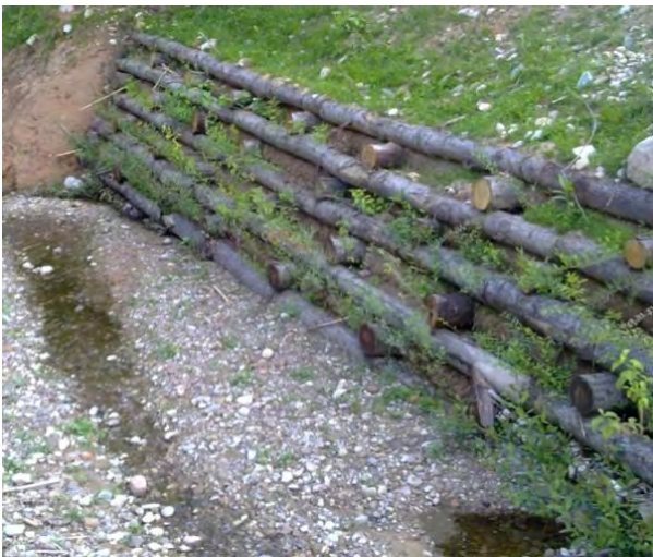
Imágenes del entramado en diferentes grados de vegetación, y finalmente ya vegetado y estructurado.
