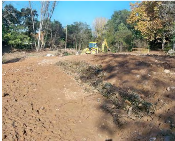
Proceso de ejecución de la ribalta
