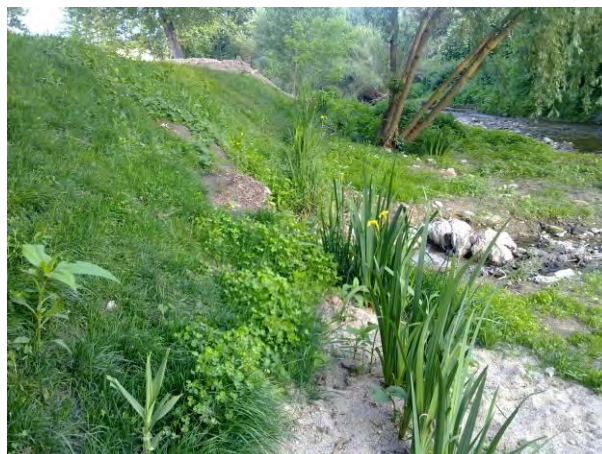
La geomalla ya vegetada y el rollo vegetalizado con los lirios.
