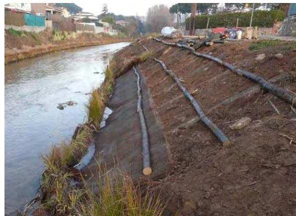
Proceso de construcción del enrejado
