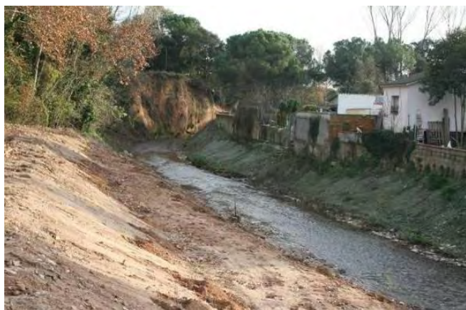
Talud reperfilado y con la aplicación de la hidromanta con fibras de algodón tipo HydraCX2 realizada.
