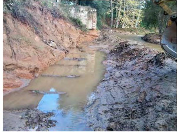
El proceso de construcción de la base y el inicio del entramado
