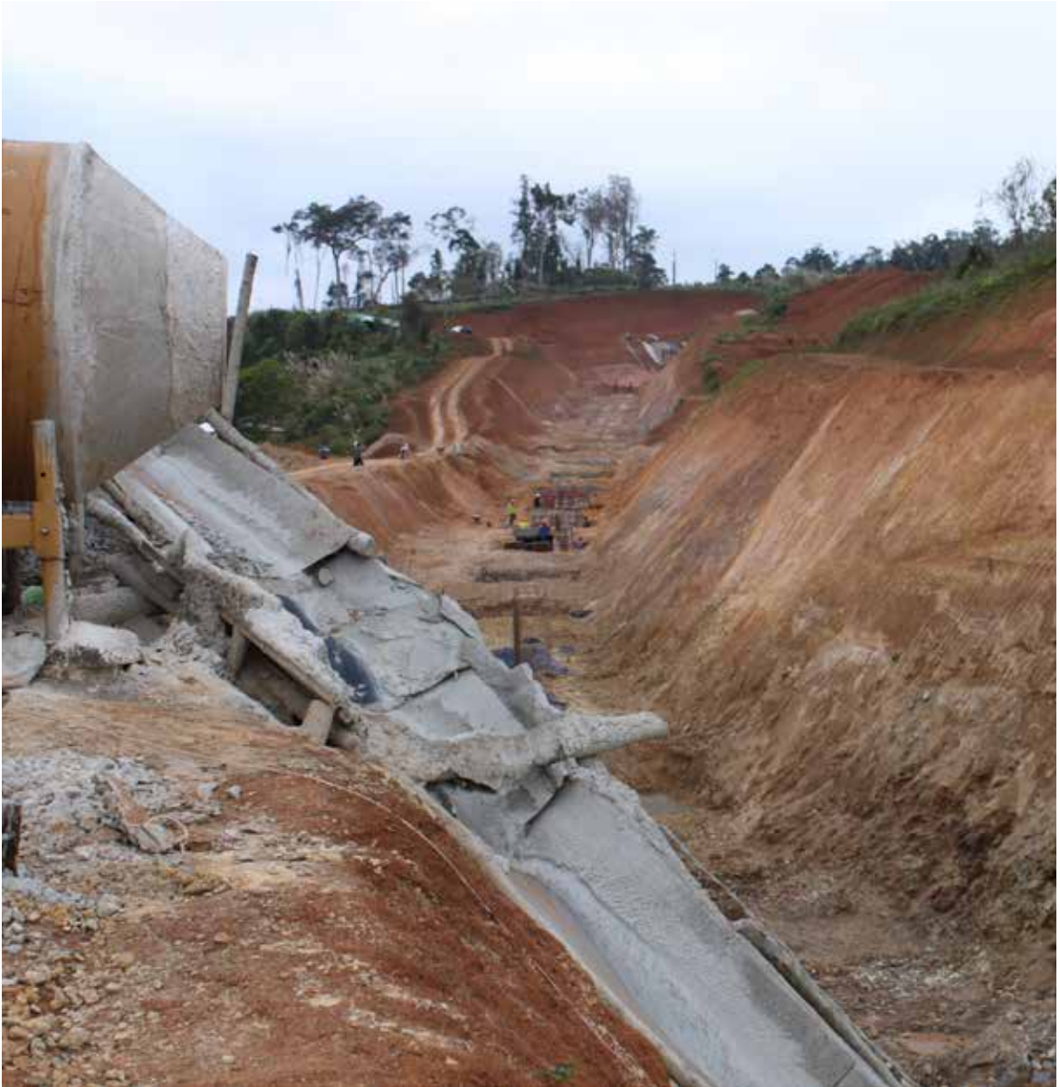
Xây dựng thủy điện ở xã Đắk Rong
