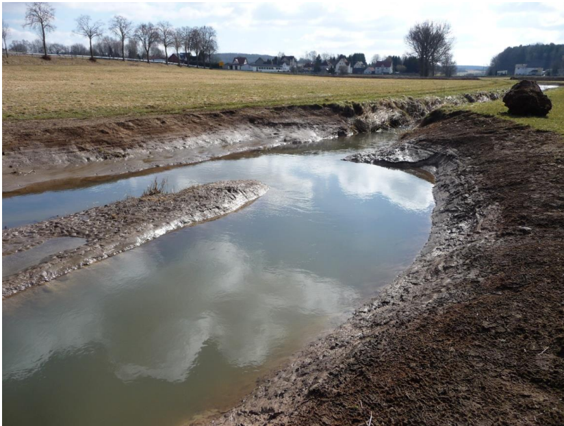
Abb. 34: Uferabflachungen, Gewässeraufweitung und Anlage von Nebengerinnen (Höfner)
