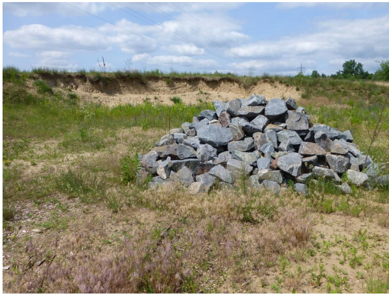
Steilwand für Uferschwalbe auf Flurstück 14/0 vor der Maßnahme Foto: Monika Göbel
