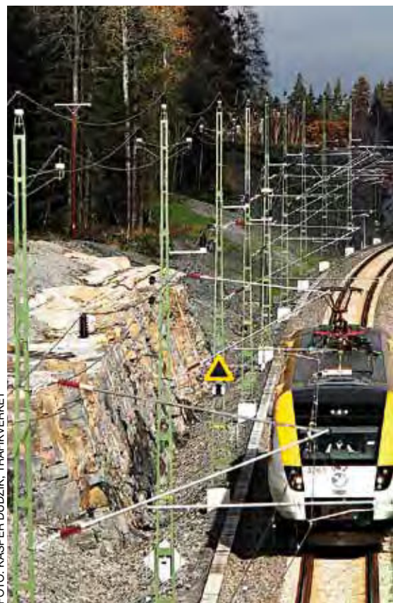
FOTO: KASPER DUDZIK, TRAFIKVERKET
